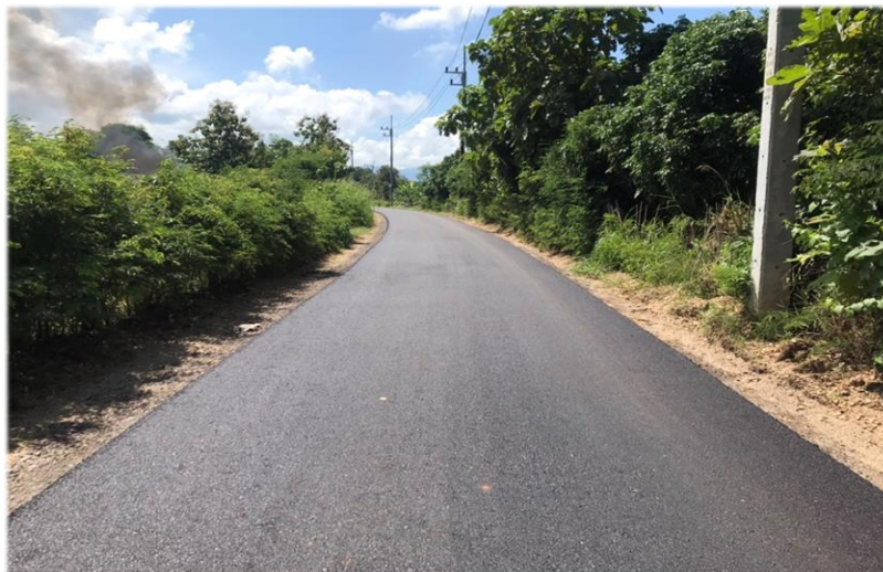
ภาพ - ดำเนินการแล้วเสร็จ
