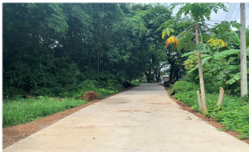
ภาพ - ดำเนินการแล้วเสร็จ
