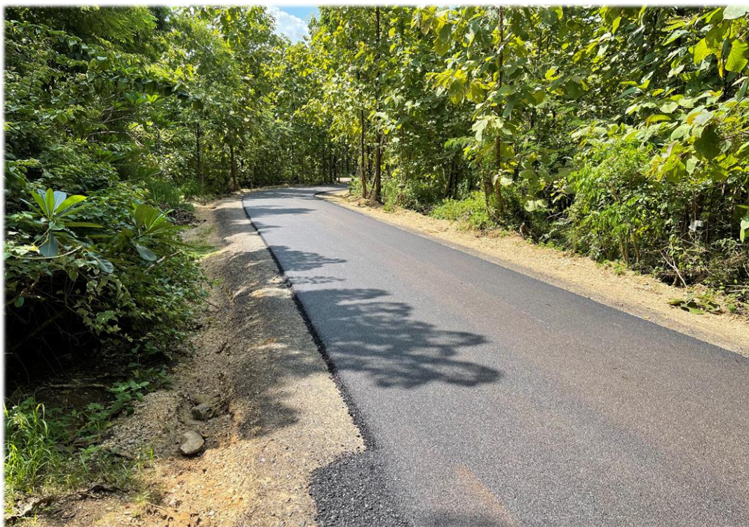
ภาพ - ดำเนินการแล้วเสร็จ
