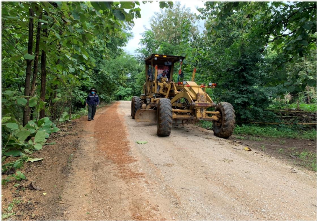
ภาพ - ก่อนดำเนินการ
